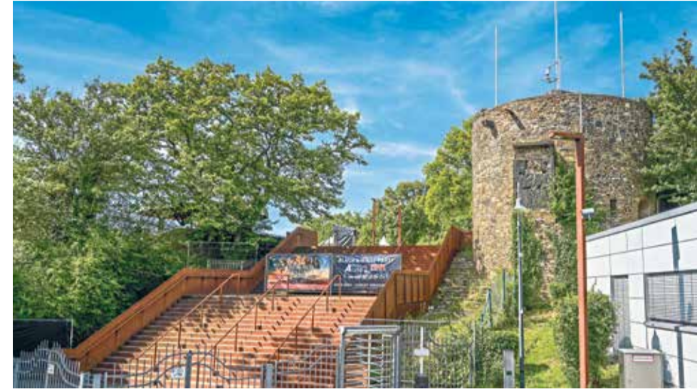
Eingang zur Freilichtbühne Loreley. Foto: Frank – stock.adobe.com
